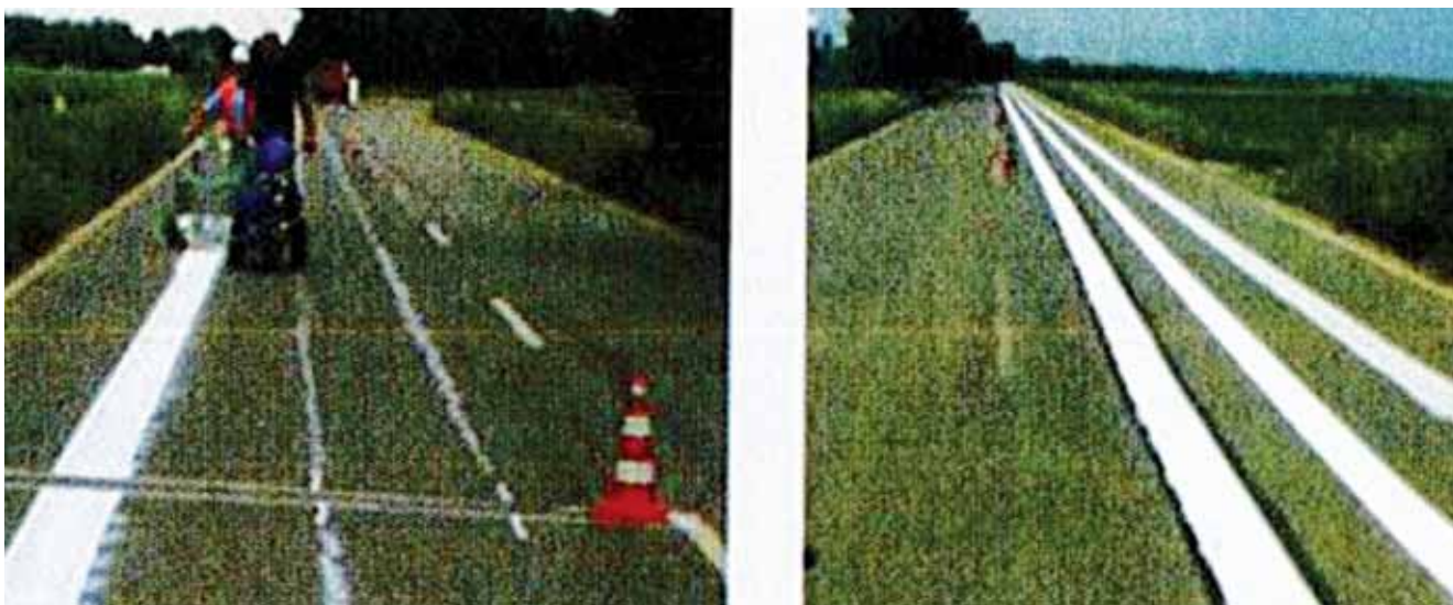
Rys. 4. Nakładanie oznakowania (str. lewa) i gotowe poletko badawcze w miejscowości Pier
