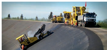
Fot. 1. Układanie asfaltu lanego na stromych ścianach zbiornika
