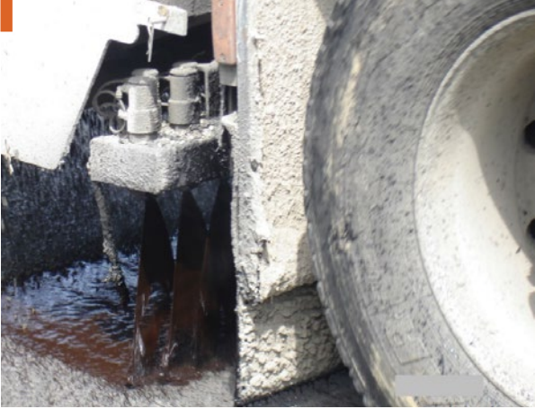
Proces jednoczesnego skrapiania emulsją oraz rozkładania kruszywa
