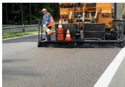
Fot. 5. Cienkie dywaniki emulsyjne układane na zimno sprawdzają się na nawierzchniach od podatnych po sztywne [źródło: Emulex Sp. z o.o.]
