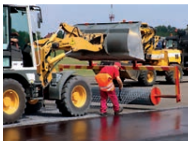
Fot. 4. Zastosowanie siatki stalowej [źródło: Bitunova Sp. z o.o.]
