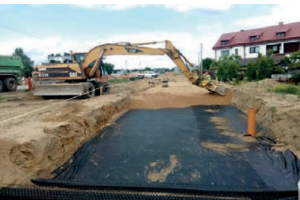
Fot. 2. Wykonywanie warstwy odcinającej; źródło: Tensar
