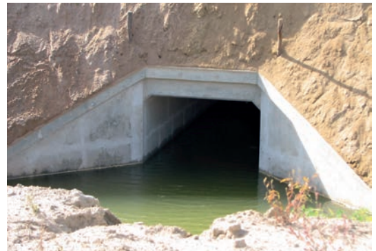
Fot. 1. Uważaj! Warstwa odsączająca musi być wyprowadzona w nasypie na krawędź skarpy, a w wykopie do drenu podłużnego lub 20 cm nad poziomem dna rowu; źródło: archiwum prywatne autorki
