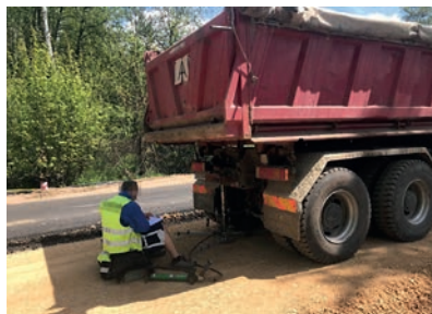
Fot. 3. DW791 Myszków–Zawiercie. Badanie nośności VSS podbudowy pomocniczej; autor: Piotr Mazurowski
