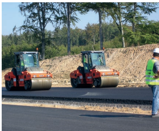
Fot. 5. Wykonanie nawierzchni asfaltowej; źródło: LOTOS Asfalt Sp. z o.o.
