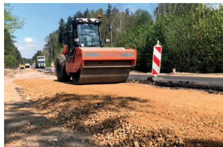
Fot. 4. DW791 Myszków–Zawiercie. Zagęszczenie podbudowy; autor: Piotr Mazurowski
